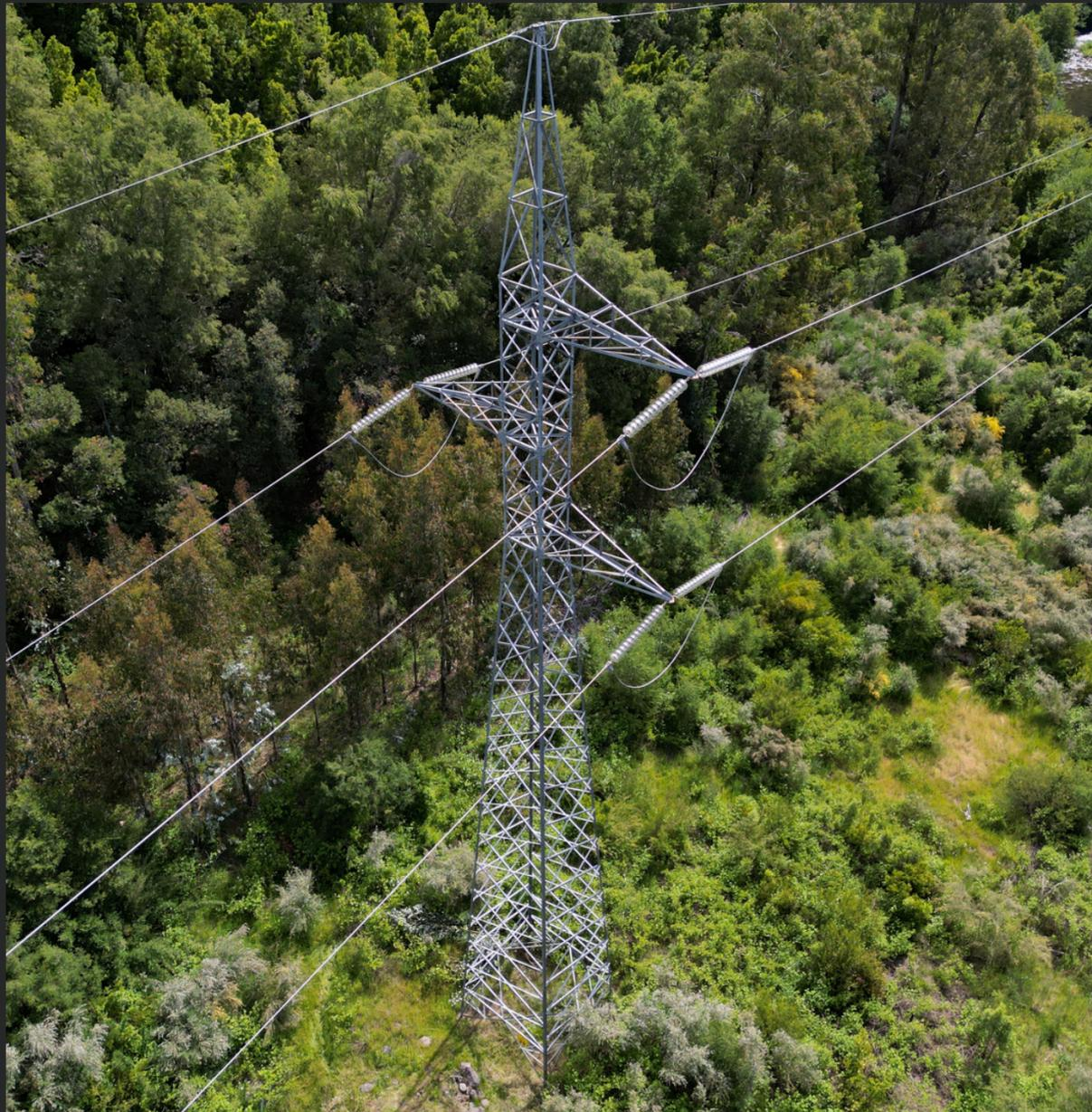
En la Inspección Normal realizamos un seguimiento a la estructura completa del activo, arboles, arbustos, faja de servidumbre, vano, etc.
